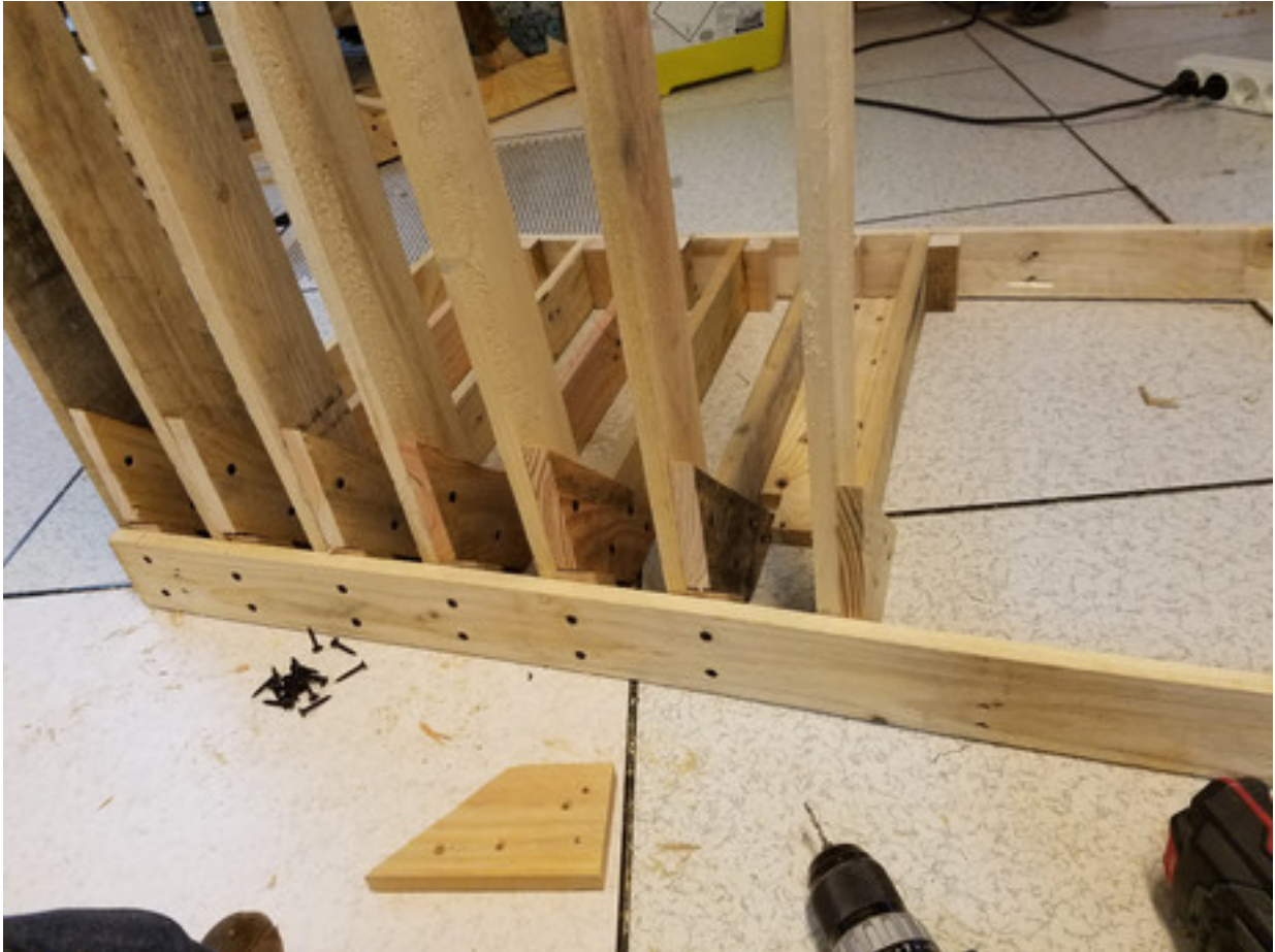
FIGURE 4.29. – et voilà déjà 7 L de vissés sur les planches de maintient
