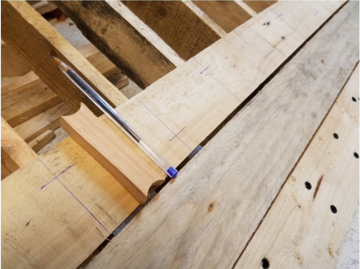
FIGURE 5.38. – marquage des trous avant perçage
