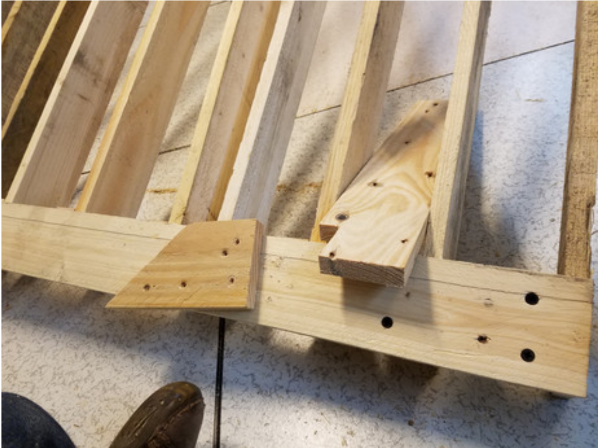
FIGURE 4.32. – vissage en cours, planche de gabarit en place
