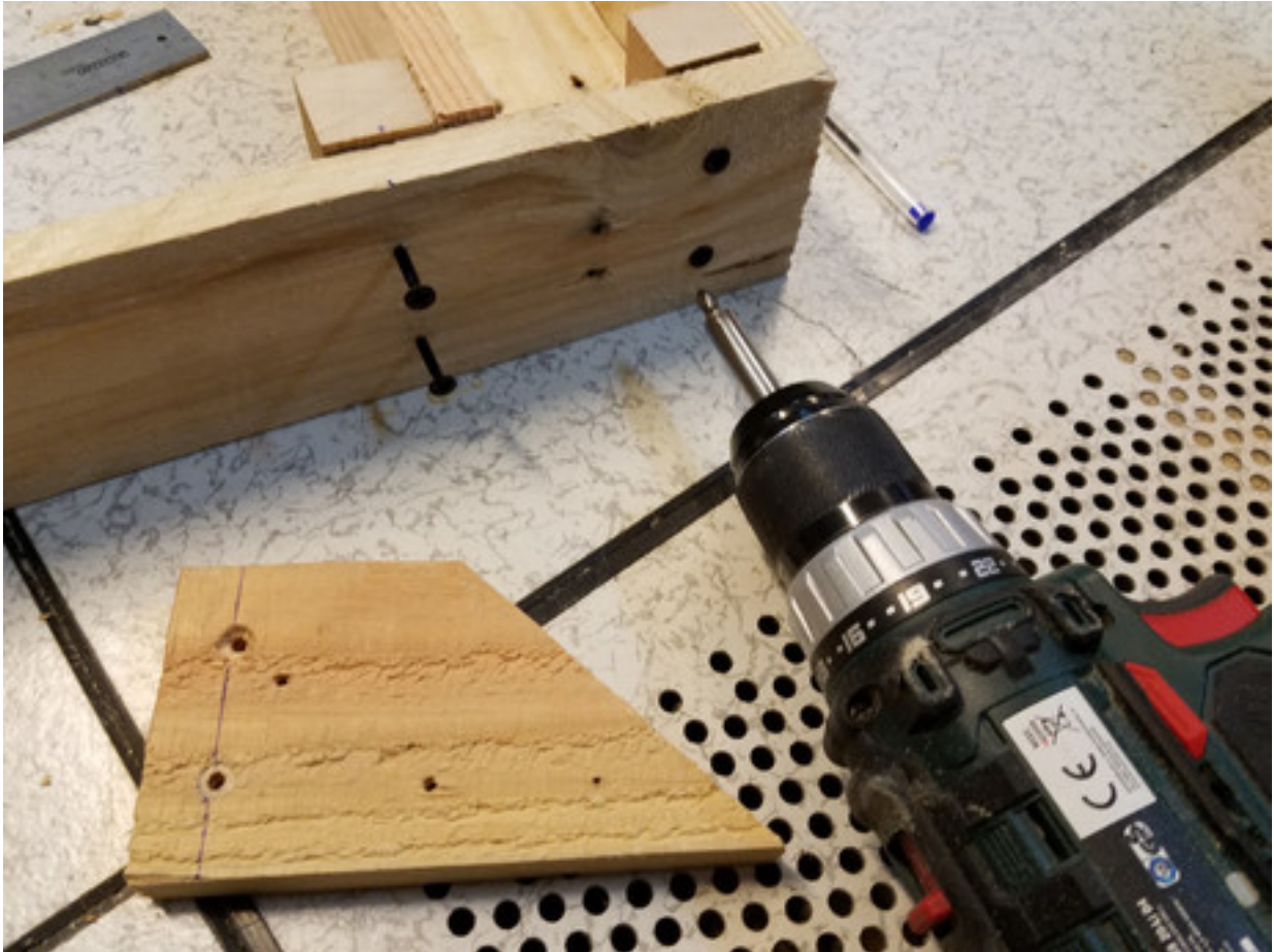
FIGURE 4.28. – vissage en cours de la 2ème équerre sur le 2ème planche de maintien
