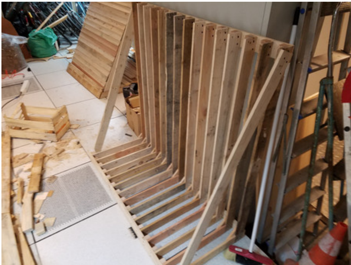
FIGURE 5.37. – structure en place avec planches diagonales
