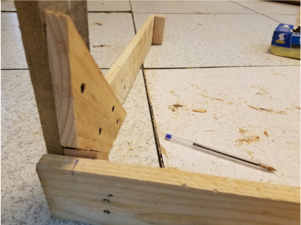
FIGURE 4.23. – Mise en place de la première planche de maintient
