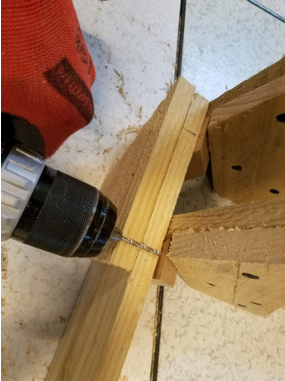
FIGURE 4.27. – pile la bonne longueur : je ne percerai pas mes cales
