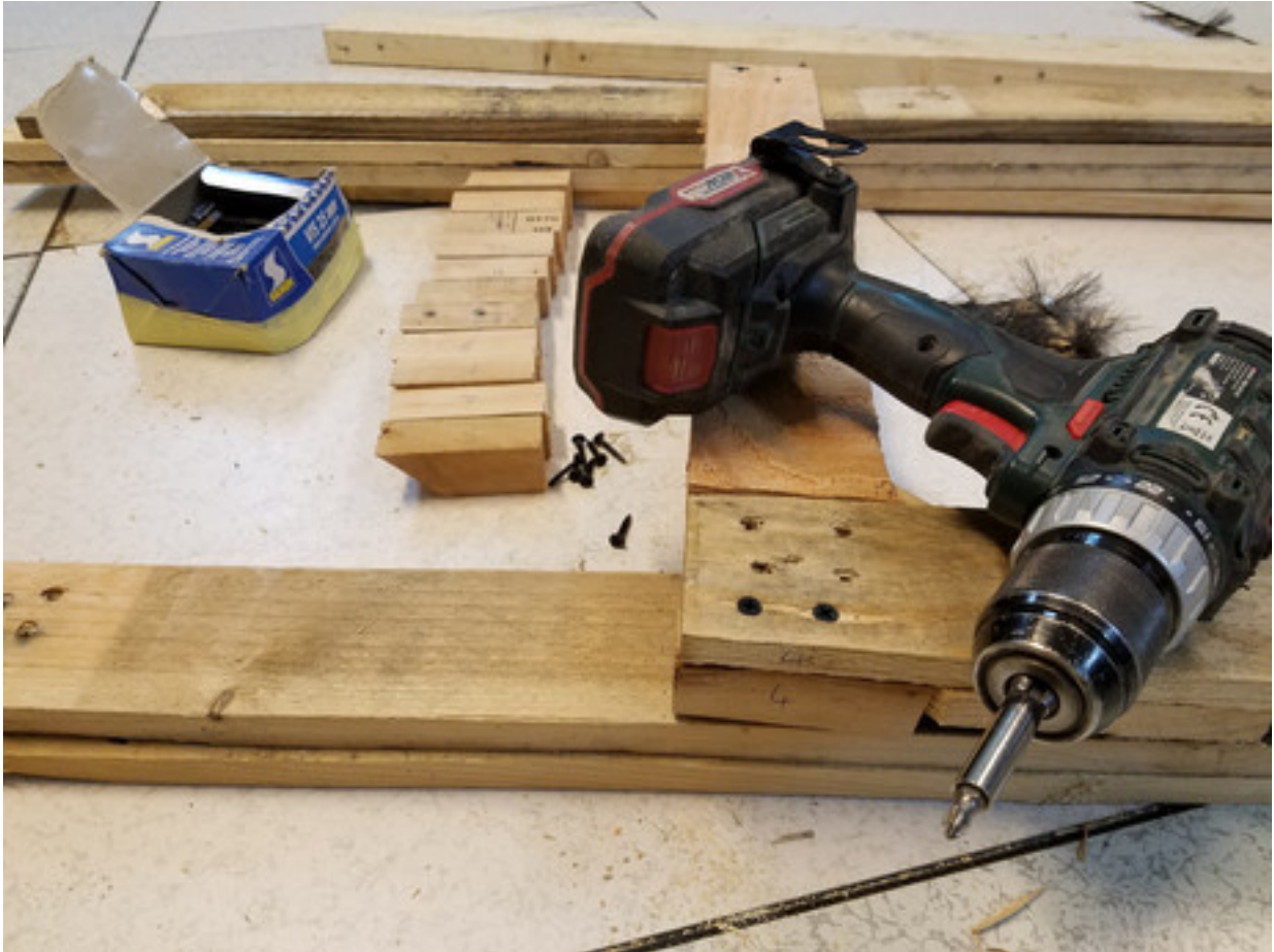
FIGURE 3.15. – première cale vissée
