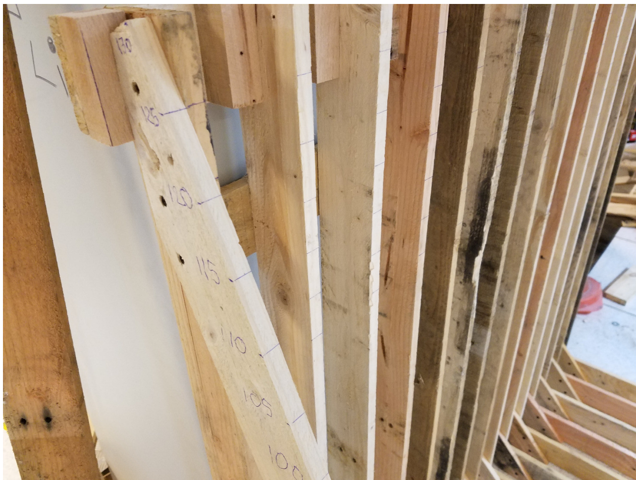
FIGURE 5.40. – les repères sont faits au stylo bille de 100cm à 130cm, tous les 5cm
