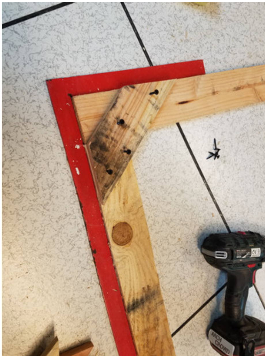
FIGURE 2.11. – vissage en cours...
